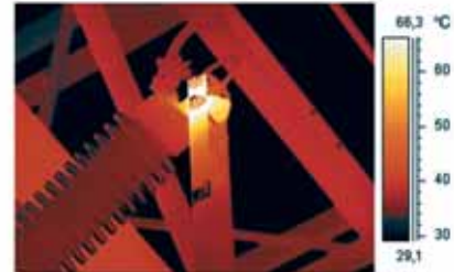
Bsp.: Defekte Verbindung an Hochspannungsleitungen
